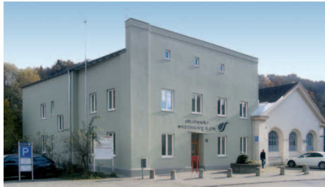
Das Betriebsgebäude der Stadtwerke Wasserburg a. Inn: Ein Beispiel einer gelungenen energieeffizienten Gebäudesanierung
